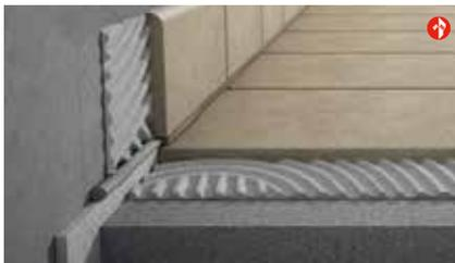
I giunti tecnici sono inseriti nelle fughe e permettono di sopportare meglio le sollecitazioni meccaniche e termo-igrometriche:
